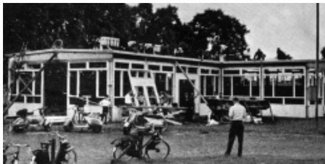
1960: De bouw van het clubhuis Varkenoord in volle gang
